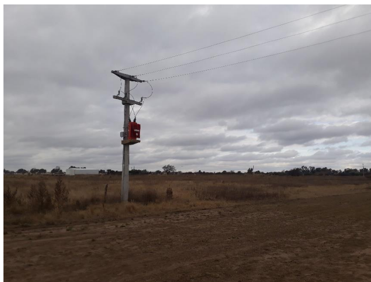
FIGURA 36: INSTALACIÓN DE TRANSFORMADOR PARA OBTENER EL MEDIDOR DE ELECTRICIDAD EN EL PROYECTO.
